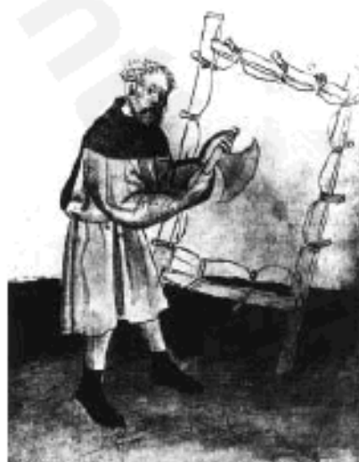
Рис. 19. Производство пергамента. Мастер обрабатывает серповидным ножом кожу, натянутую на деревянную раму. Рисунок пером в рукописи Nürnberg, Stadtbibliothek Amb. 317, fol. 34v (ок. 1425 г.).
